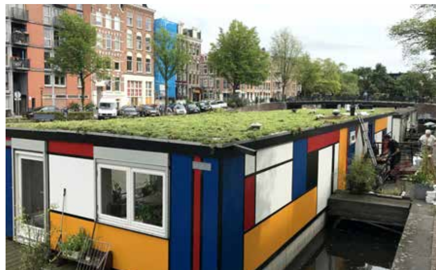
De woonboot van Ella en Peter in Amsterdam, voorzien van lichtgewicht Sedumdak.
