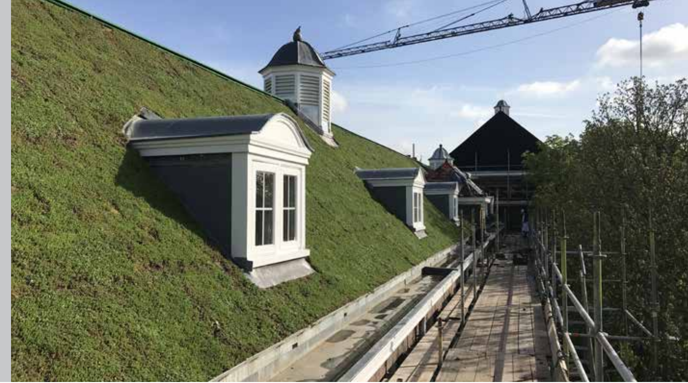
Dakrenovatie van historisch pand De Ottoburg in Rijswijk.
